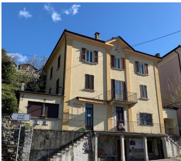
Immagine 11: Vista frontale Osteria - lato sinistro
